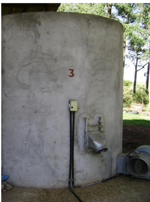
FIGURA 2. Silo secador em alvenaria, com ventilação forçada de ar em temperatura ambiente. Eldorado do Sul, RS. 2011/2012.
